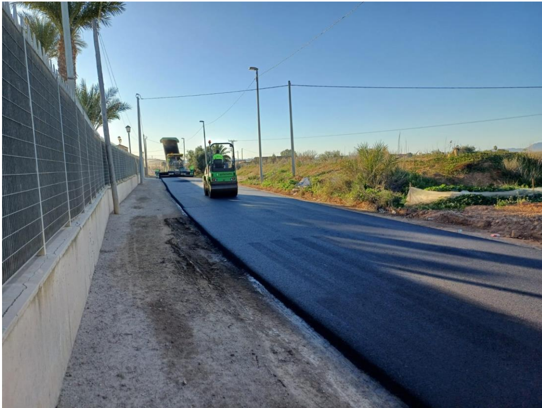
Figura 26. Reparación de un camino de servicio en el T.M. de Torre-Pacheco.
