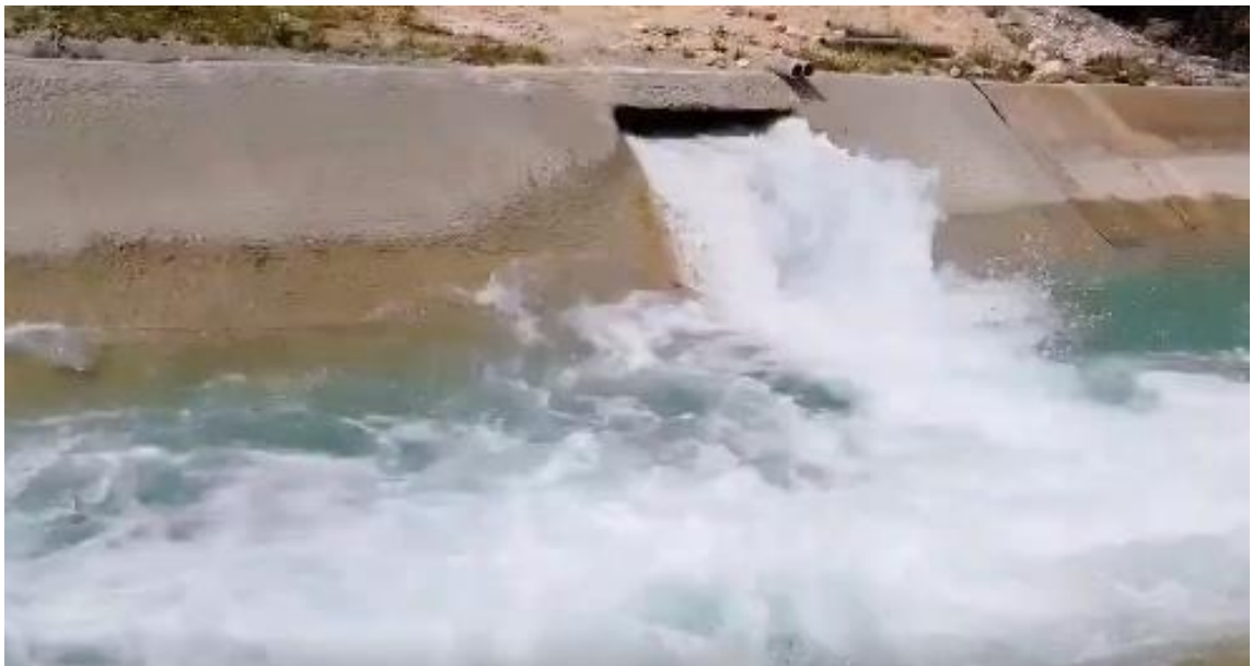
Figura 5. Punto de suministro del agua de la Desaladora de Torrevieja en el Canal Principal
