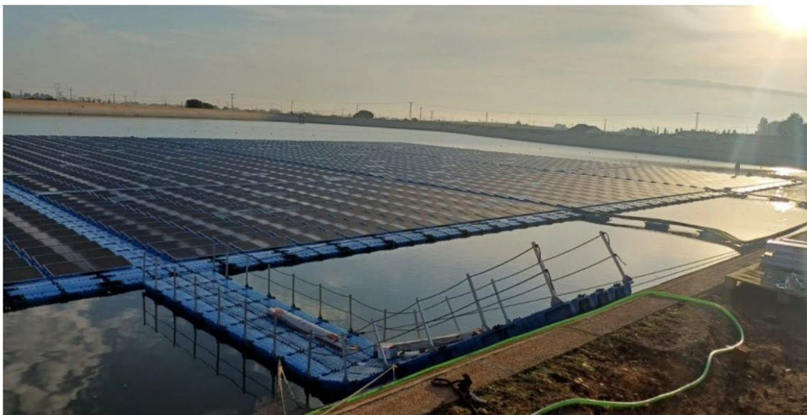
Figura 38. Planta fotovoltaica flotante para autoconsumo del embalse de Cola.
