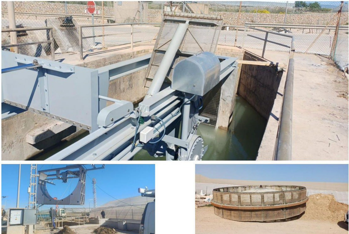
Figura 19. Trabajos de sustitución del filtro T-IV-V.
