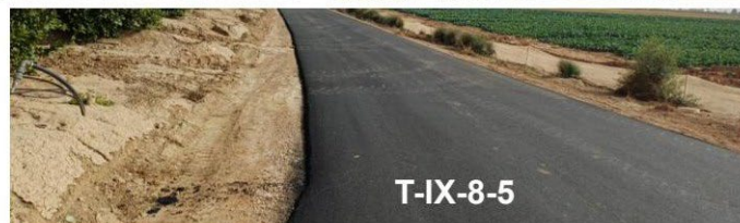
Figura 21. Actuaciones de asfalto en continuo en diversos caminos de servicio.
